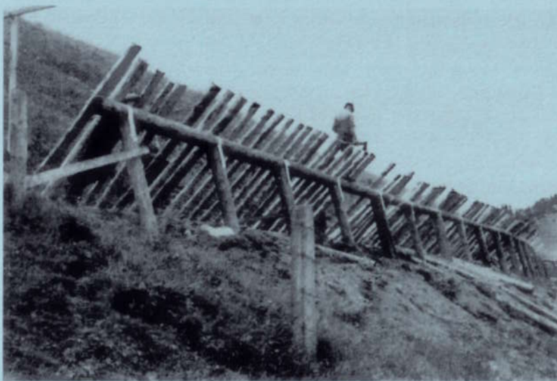
Stützwerte im Bau 1977
