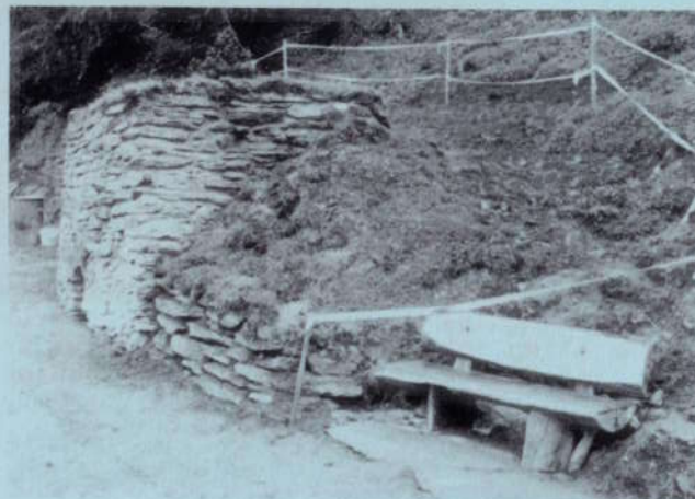
Aussen-Ansicht nach der Sanierung
