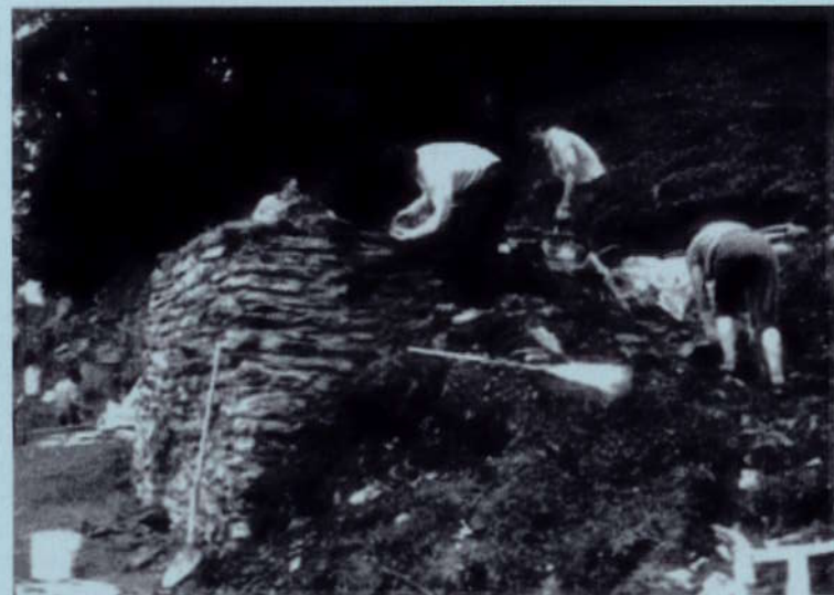
1989 Sanierung Kalkofen Hintere Alp
