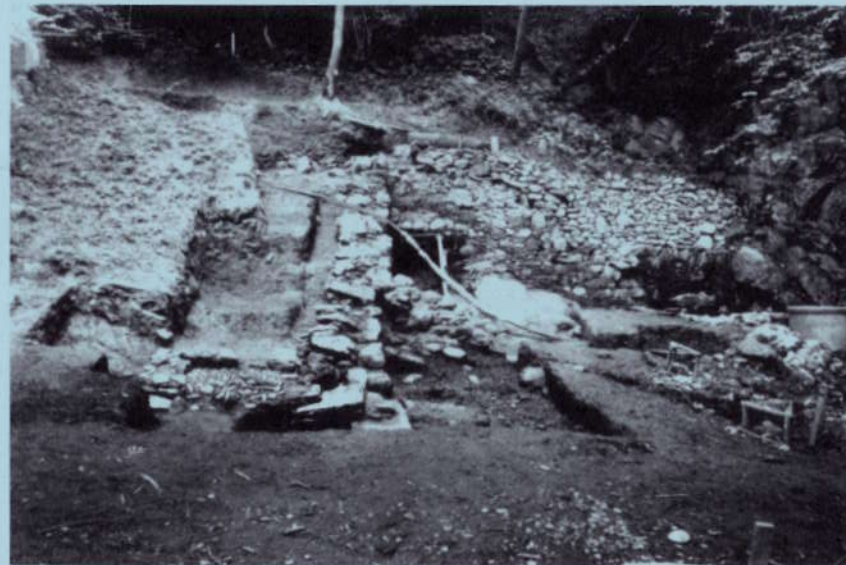
1991-1993 Sanierung Bad Friewis
