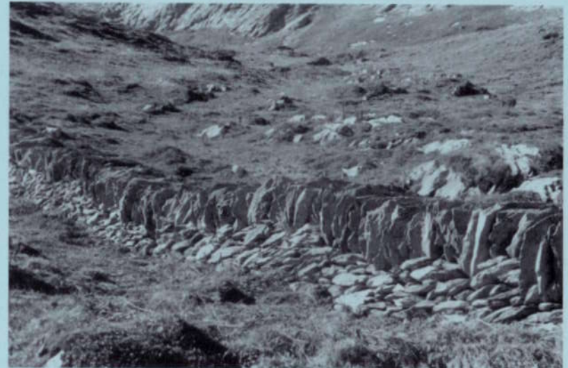
Ein erneuertes Teilstück
