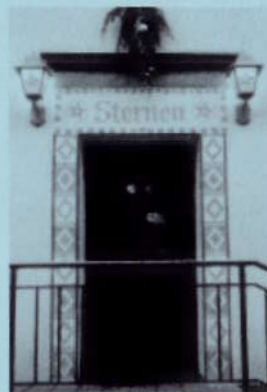
5 Neu gestalteter Gaststübeneingang, darüber die originale Verdachung.
