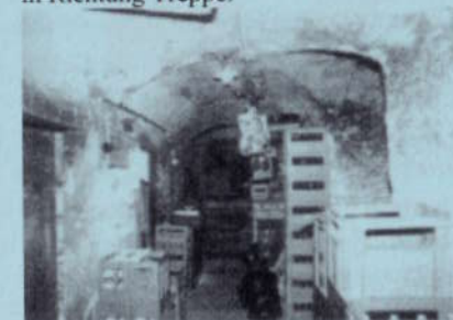
Unten: 2 Gewölbegang im Keller, Blick in Richtung Treppe.
