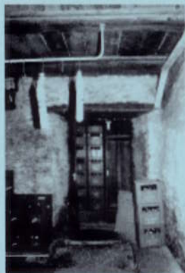
4 Kellerraum KE 2. Vor der Schwelle in den Gewölbegang liegt eine grosse Steinplatte. Originale Holzbalkendecke.
