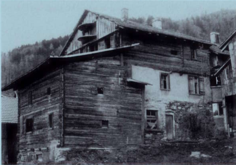
Abb.1 Die Häusergruppe Kronengasse 121/122 in Untervaz weist eine interessante baugeschichtliche Entwicklung auf. Die ältesten Baureste stammen aus dem 13. Jahrhundert. (Photo Kantonale Denkmalpflege GR)
