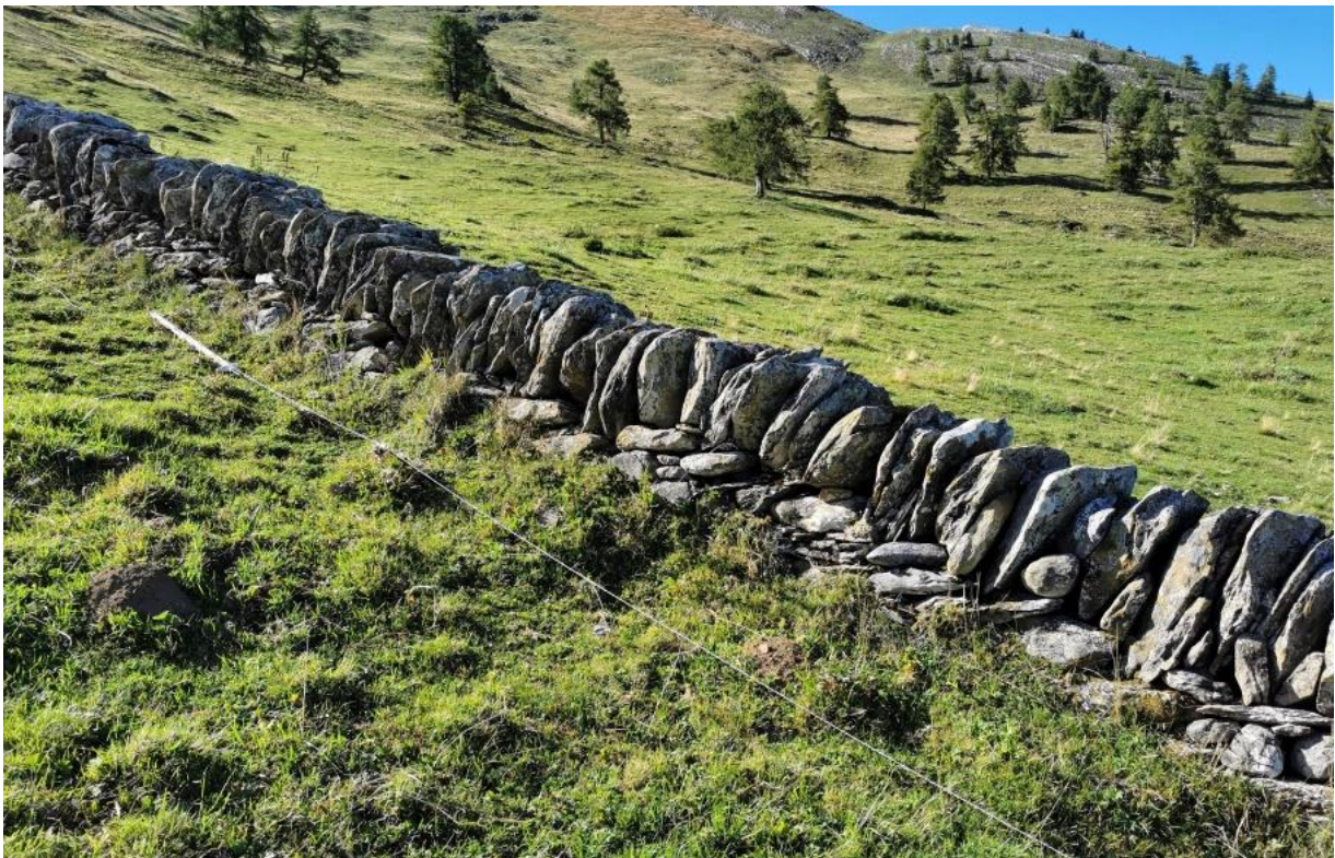
Abbildung 3: Mauerkrone der Natursteinmauer
