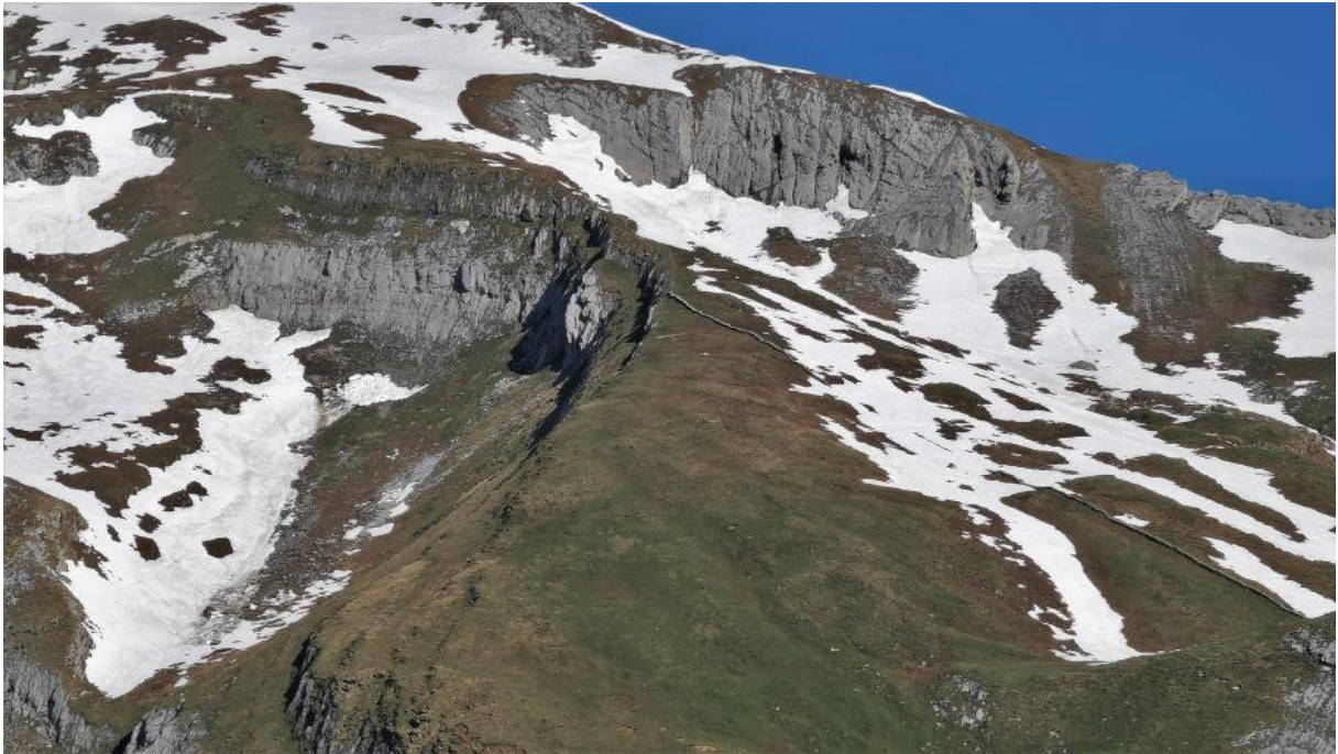
Abbildung 4: Oberes Ende der Grenzmauer auf ca. 2.277 m Höhe an der Rossfalla
