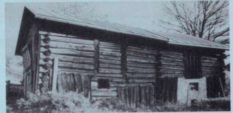
Doppelstall-Südseite: mit verändertem Heueinwurf links und teilweise gemauerter Stallwand rechts.
