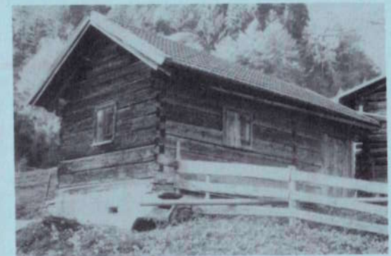
Verzahnter Blockbau (Montafoner-Strick).
