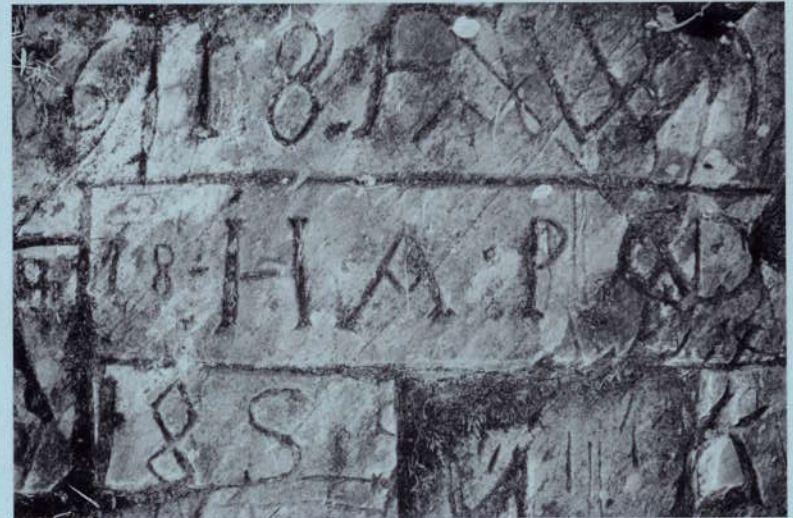
Fotos der Meisselarbeiten am Felskopf ob dem Brotjoggliwegli
