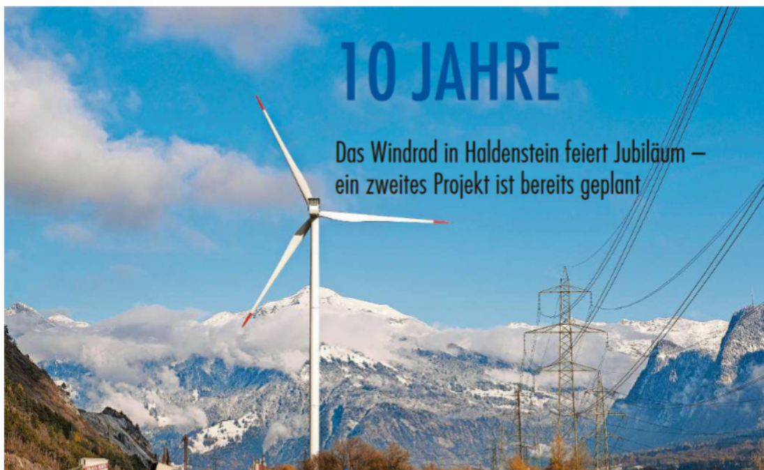
Das erste und bisher einzige Windrad in Graubünden wurde vor zehn Jahren in Haldenstein gebaut.
